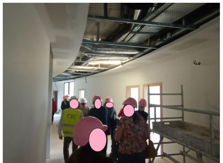
Couloir du 1 er étage
